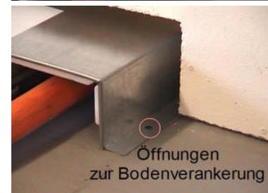
5. Löcher zum Festdübeln in den Beton bohren.
